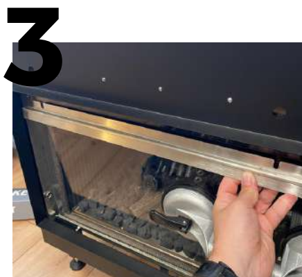
3 Вставьте металлическую пластину и закрутите болты
